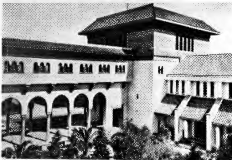
Casablanca, le Palais de Justice, 1915, architecte J. Marrast.
