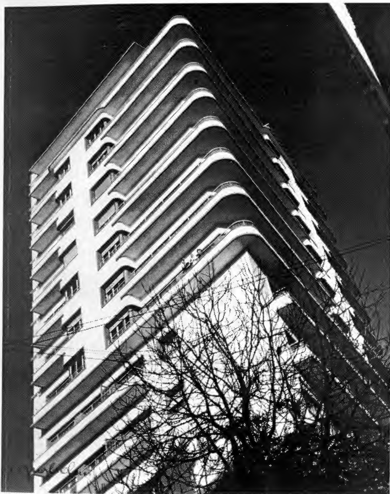
Un très bel immeuble construit par Jacques Vidal.
