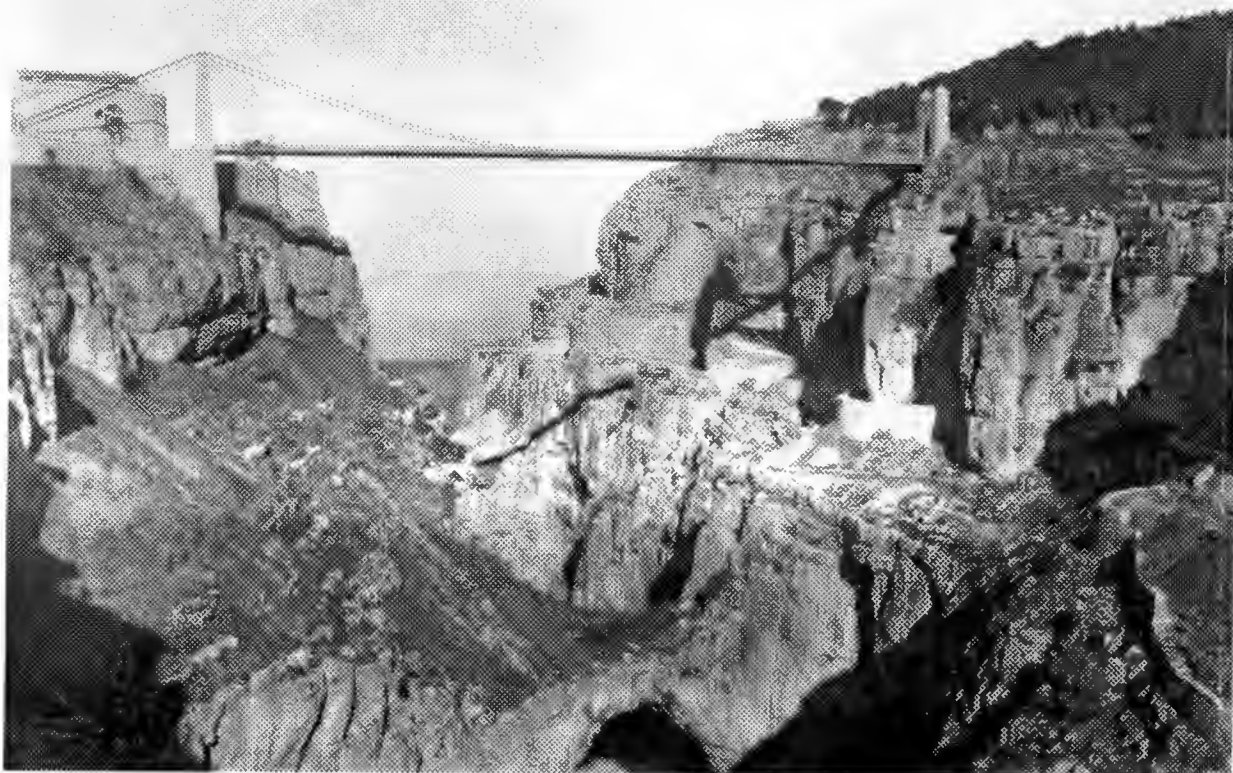
Le pont suspendu de Sidi M'Cid, 185 m au-dessus du Rhummel, 170 m de long.
