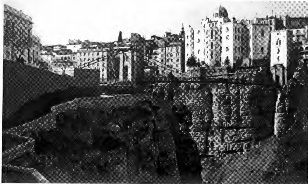
La passerelle Perrégaux (1923), pont métallique de 125 m de long et 2,40 m de large n'était que piétonne, mais facilitait la circulation de la rue Nationale vers la gare au-dessus du Rhummel.
